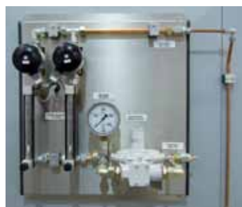
Газационная система для негорючего защитного или реакционного газа
